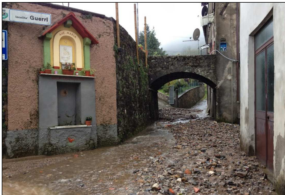
Figura 8.2 – Galliciano loc. Guerri in occasione della piena dell'anno 2013 – Si nota il deposito di materiale lapideo seppur con altezze molto limitate
