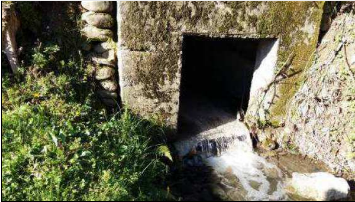
Figura 8.1 – Sbocco di uno dei due canali della parte sud di Galliciano analizzati: si nota una luce piuttosto ampia in relazione alle condotte presenti a monte per l'attraversamento della viabilità provinciale
