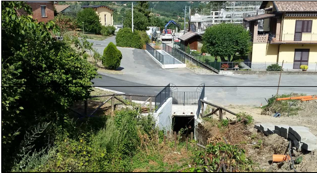
Figura 8.5 – Fosso di Materceta: in evidenza gli interventi di sistemazione (ampliamento del tombamento e pettini per la ritenzione del materiale solido trasportato dalla corrente)
