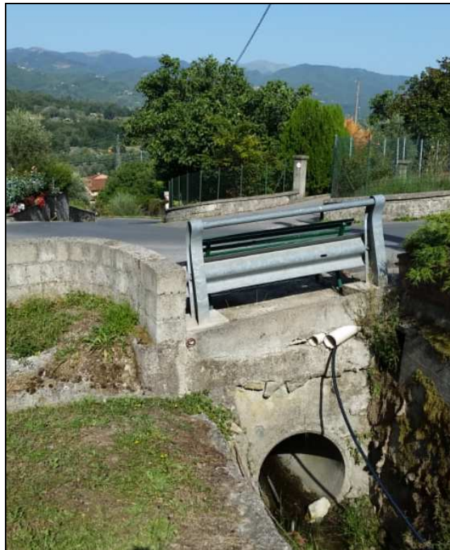
Figura 7.26 – Attraversamento sul fosso Focchia realizzato con condotta circolare inferiore ad 1m di diametro
