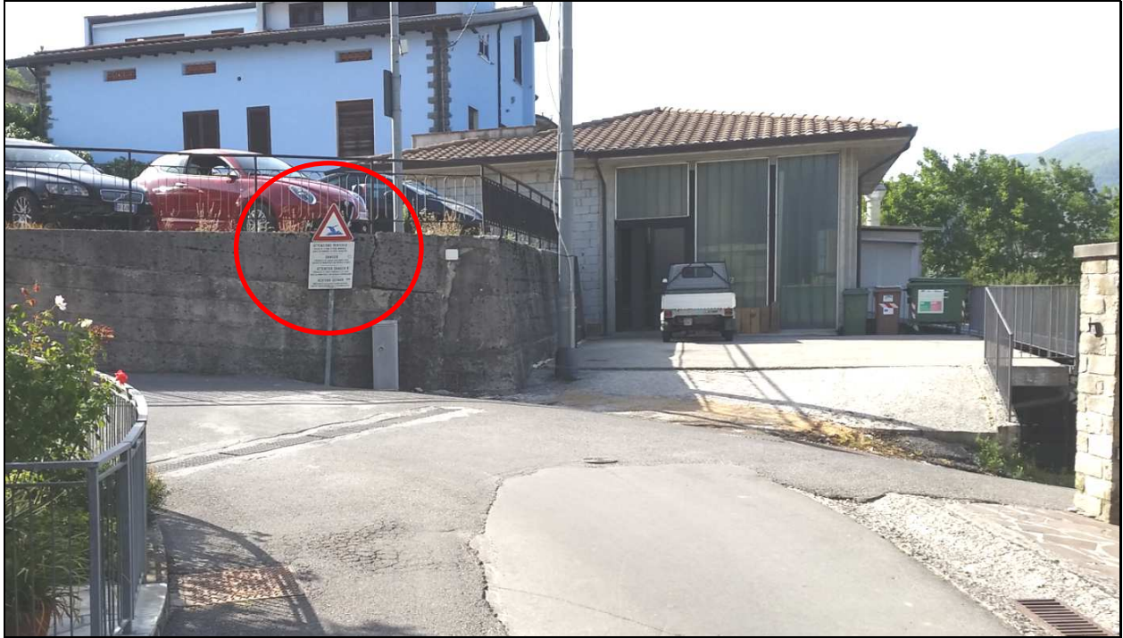
Figura 7.25 – Filicaia – Cartellonistica che indica possibilità di esondazioni. In evidenza anche il contesto piuttosto acclive delle strade ivi presenti.
