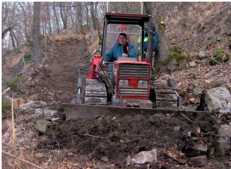
51. Apertura del tracciato con apripista cingolato
