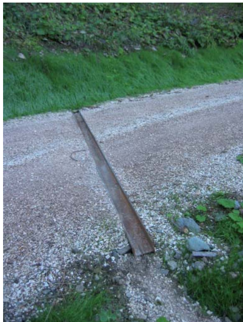
45. Canaletta realizzata in trave HE di metallo
