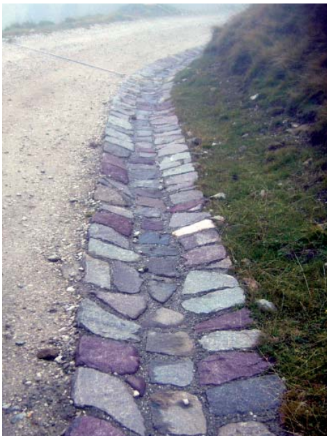
35. Cunetta longitudinale lastricata
