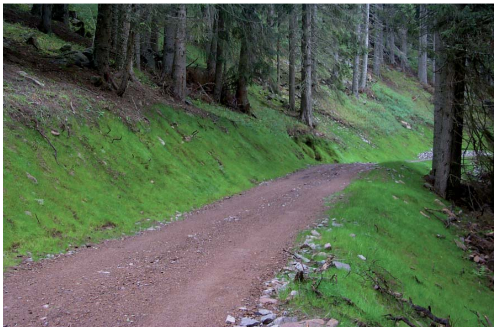
28. Inerbimento della scarpata
