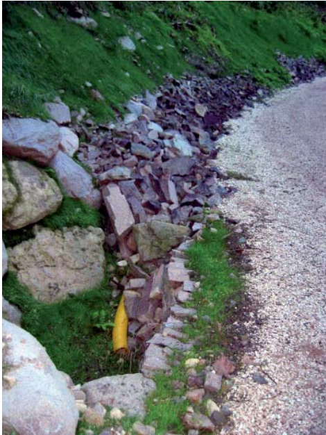
34. Cunetta filtrante con drenaggio
