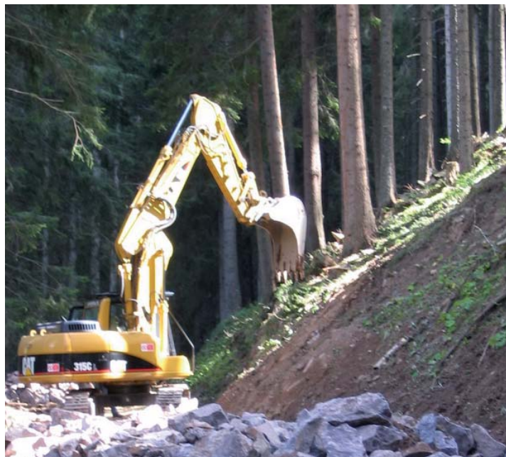
53. Scoronamento della scarpata a monte con escavatore
