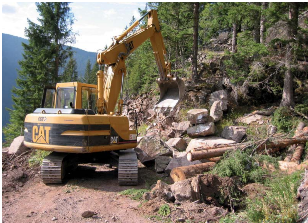
52. Apertura del tracciato con escavatore cingolato
