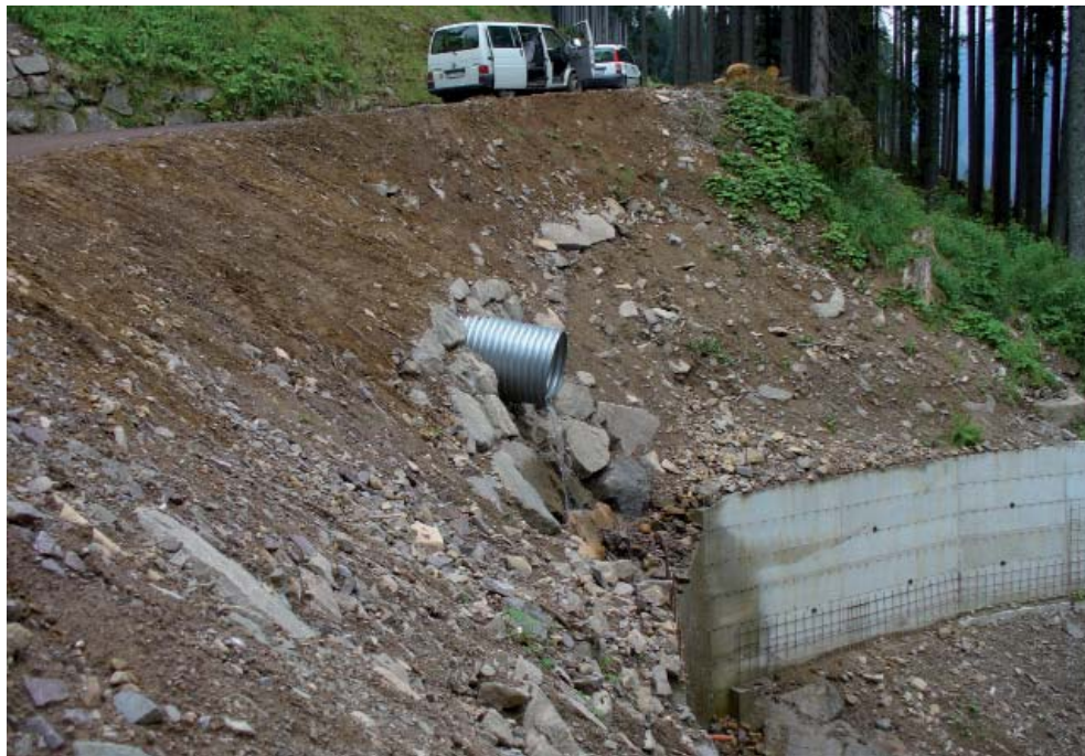
47. Muro di sostegno in calcestruzzo armato
