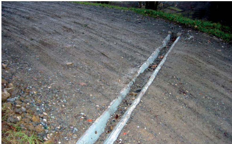
43. Canaletta realizzata in lamiera
