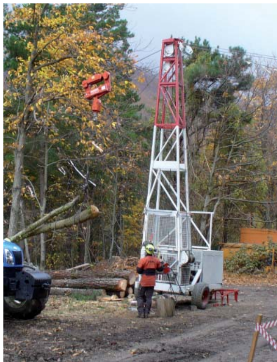
9. Esbosco con gru a cavo con stazione motrice mobile (tipo leggero)
