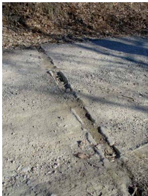
43. Canaletta realizzata in lamiera
